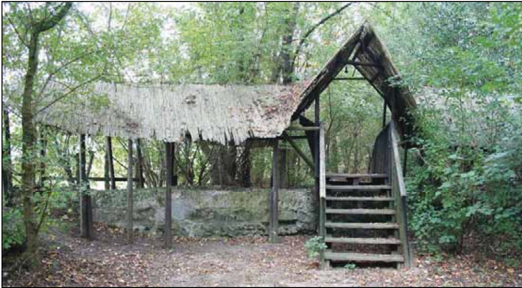
Abb. 25: Leitungsfragment am Landgasthof Strattmann in Labbeck mit einer Treppe zum Übergang auf die andere Kanalseite.
