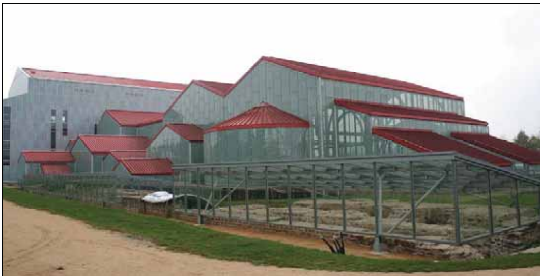
Abb. 1: Blick auf die Nordecke der Großen Thermen in Xanten. Im Bild unten unter einem Schutzdach die Fundamente des Wasser-Hochbehälters, dahinter der Schutzbau über den Thermen, links quer davor der Museumsneubau über den Grundmauern der basilica thermarum (Zustand November 2006).
