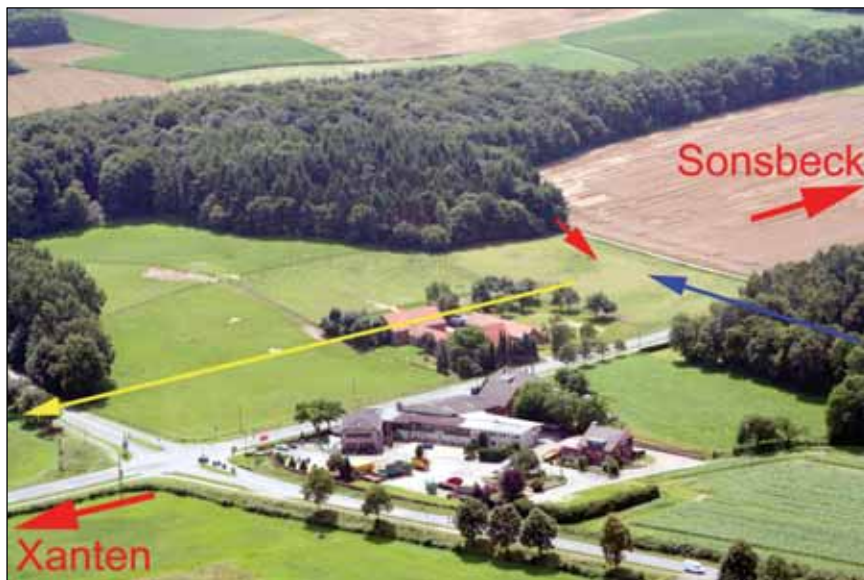
Abb. 31: Vermuteter Treffpunkt der Teilleitungen auf einer Wiese (Sonsbecker Seite eines Bauernhofes) [rot: Ende der neuen Trasse / blau: Ende der schon bekannten Trasse / gelb: Weiterleitung Richtung Aquädukt].
