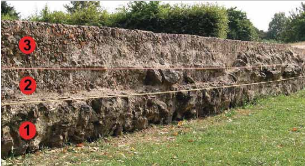
Abb. 33: Deutlich erkennbare Schichtungen in der Ummantelungsmauer am Leitungsfragment im APX.
