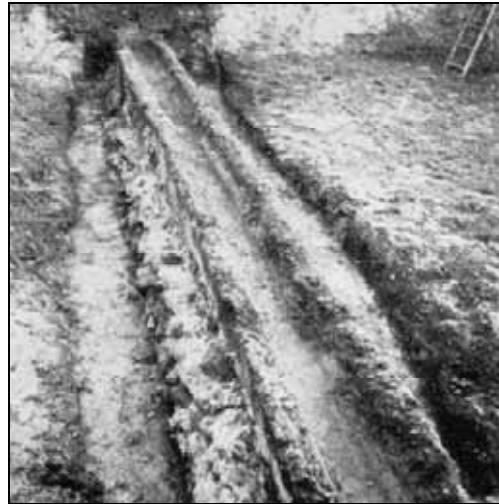
Abb. 13: Wasserleitung in einer Baugrube am Holzweg in Xanten; Oktober 1959 (Quelle: Hinz 1959, 17).
