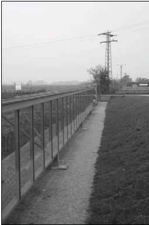
Abb. 2: Blick nach Norden. Unter dem Schutzdach die Fundamente des Hochbehälters (vgl. Abb. 1).
